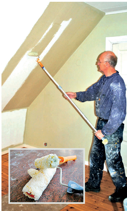
Malowanie wałkiem ścian z tapetą.
