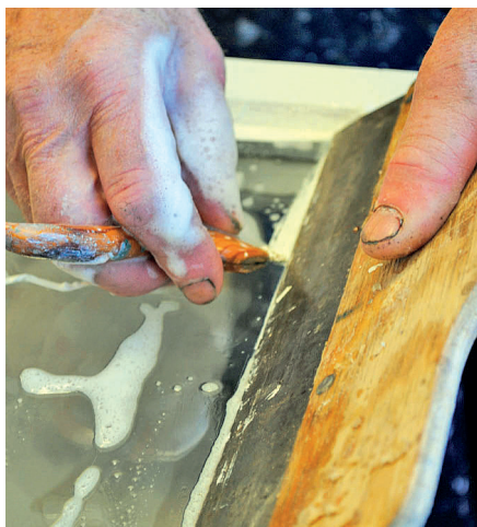
Wycinanie nadmiaru kitu z wodą z mydłem.
