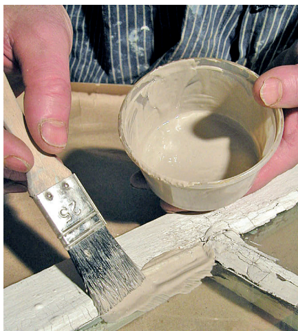
Rozcierczony kit, metoda „opóźniająca starzenie”
